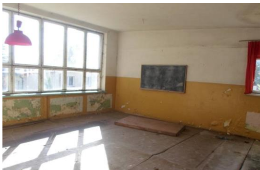
Zdjęcie 4. Budynek szkoły w Sądziecznie
