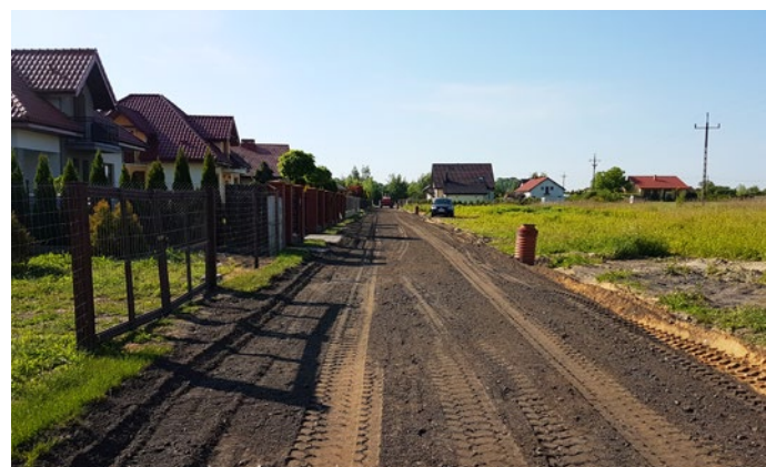
Wykonano podbudowę drogi na ul. Śliwkowej w Brzozówce
