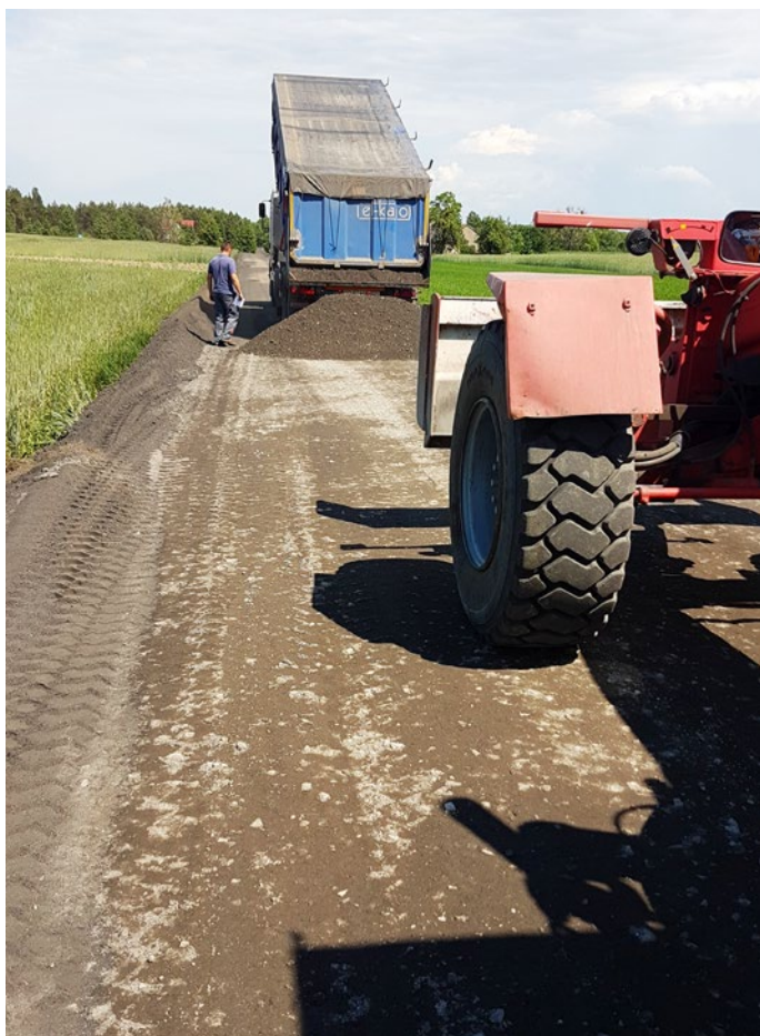
Trwają prace przy podbudowie drogi na ul. Szembeka w Szembekowie
