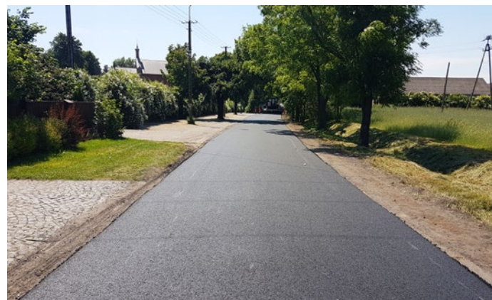
Wylano asfalt na ul. Kościelnej w Głogowie
