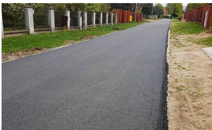
Wylano asfalt na ul. Jodłowej w Brzozówce
