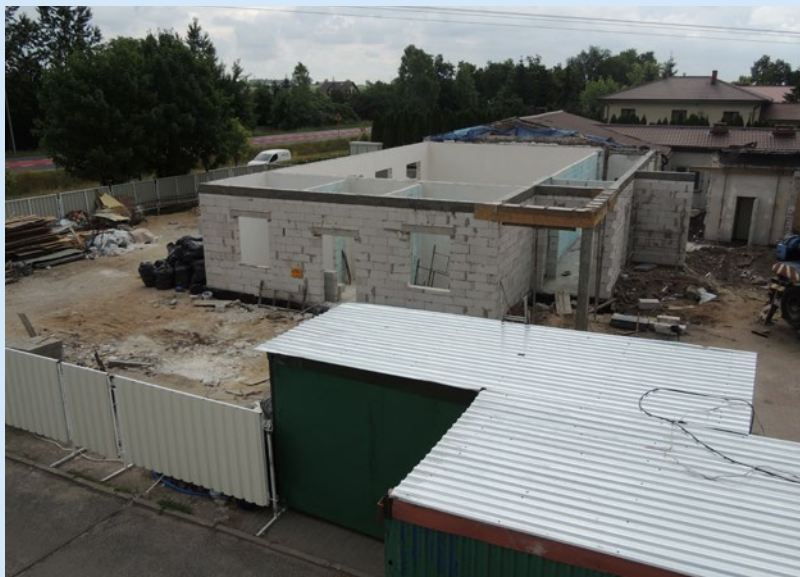
Remont i rozbudowa budynku świetlicy wiejskiej w Obrowie - czerwiec 2018
