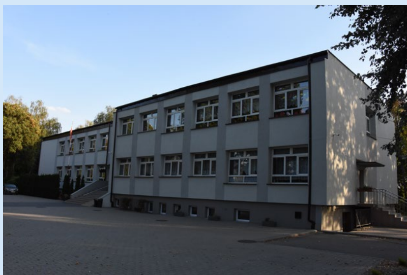
Budynek SP w Łążyń II po termomodernizacji
