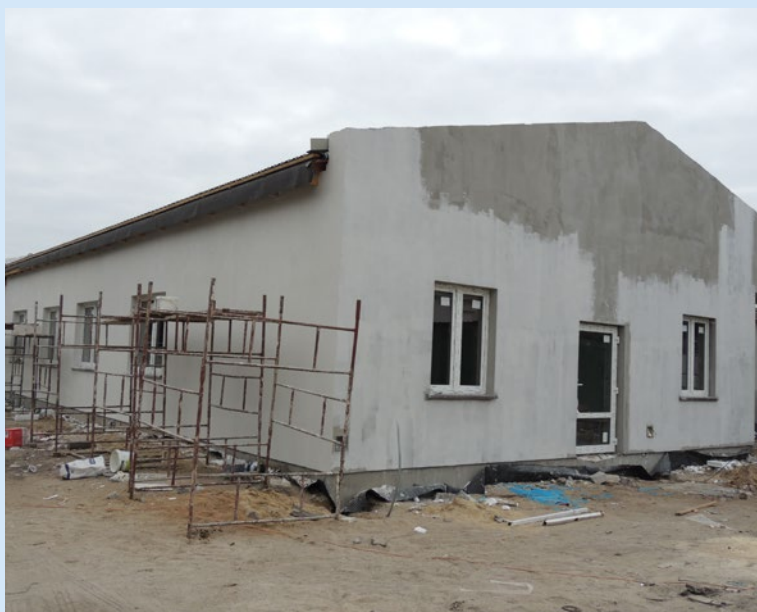
Remont i rozbudowa budynku świetlicy wiejskiej w Obrowie - październik 2018
