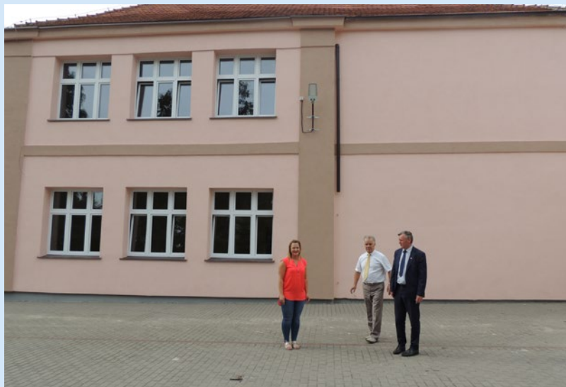
Budynek SP w Dobrzejewicach po termomodernizacji
